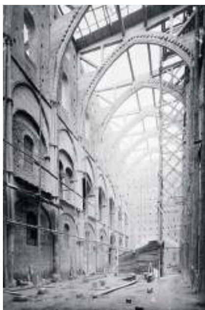
Abbildung 36 - Wiederaufbau des Kirchenschiffs (1920er Jahre) © Kultusministerium - Mediothek der Architektur des Erbes. (RMN-Verteilung)
