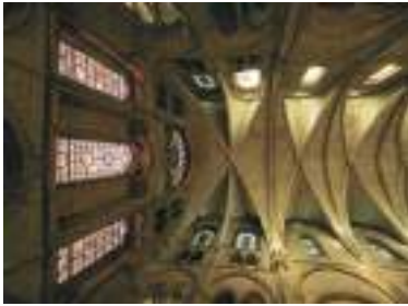
Abbildung 24 - Kreuzrippengewölbe aus dem späten 12. Jahrhundert - Foto TD
